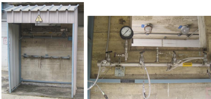
Figura 8-30 y 8-31: Caseta de botellas de oxígeno (izquierda) y detalle de su contenido (derecha)
