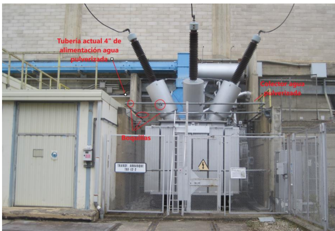
Figura 8-15: Transformador de arranque con detalle sistema de extinción automática
