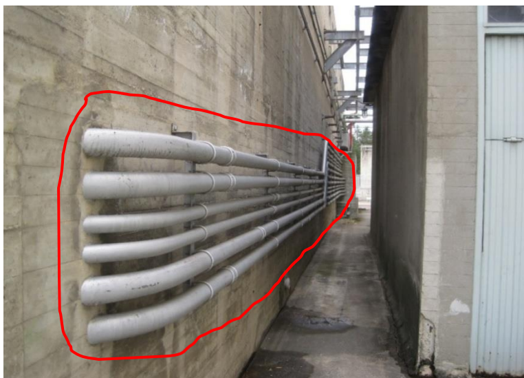
Figura 8-24: Conduits sobre fachada norte de transformadores principales
