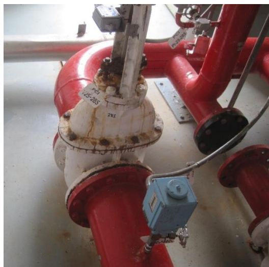
Figura 8-17: Tubería de 8" y válvula PCI V25-285
