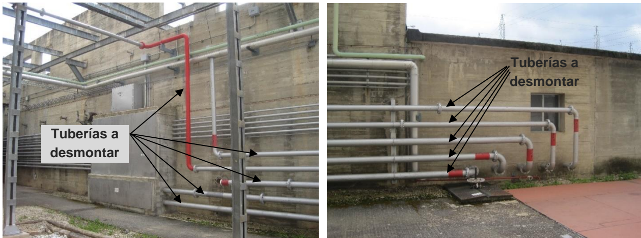
Figura 8-19 y 8-20: Tuberías del sistema contra incendios
