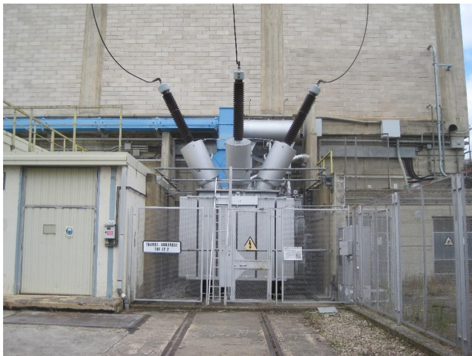
Figura 4-9: Transformador de arranque
