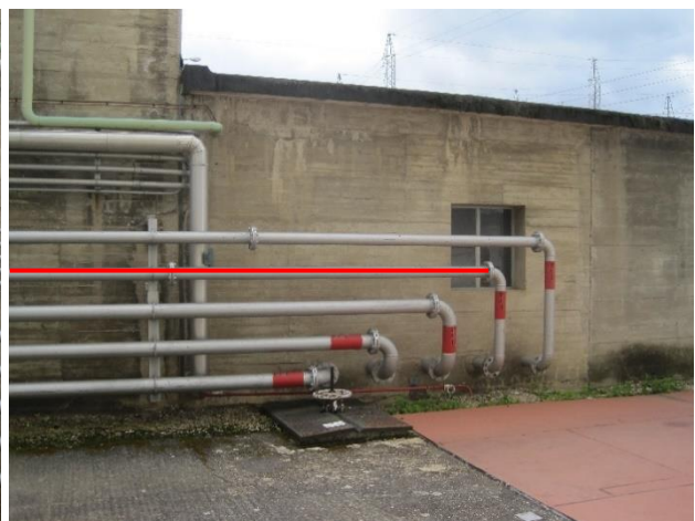
Figura 4-12 y 4-13: Tuberías del sistema contra incendios
