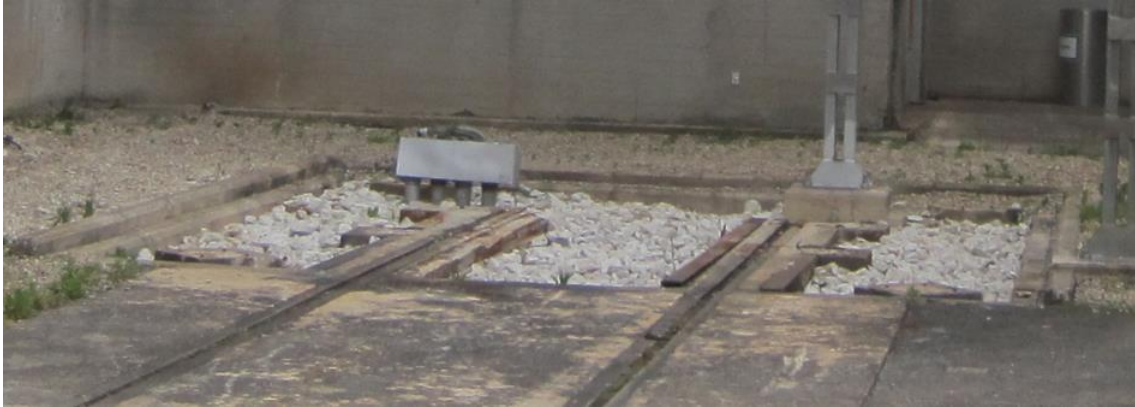
Figura 8-47: Cubeto transformador auxiliar
