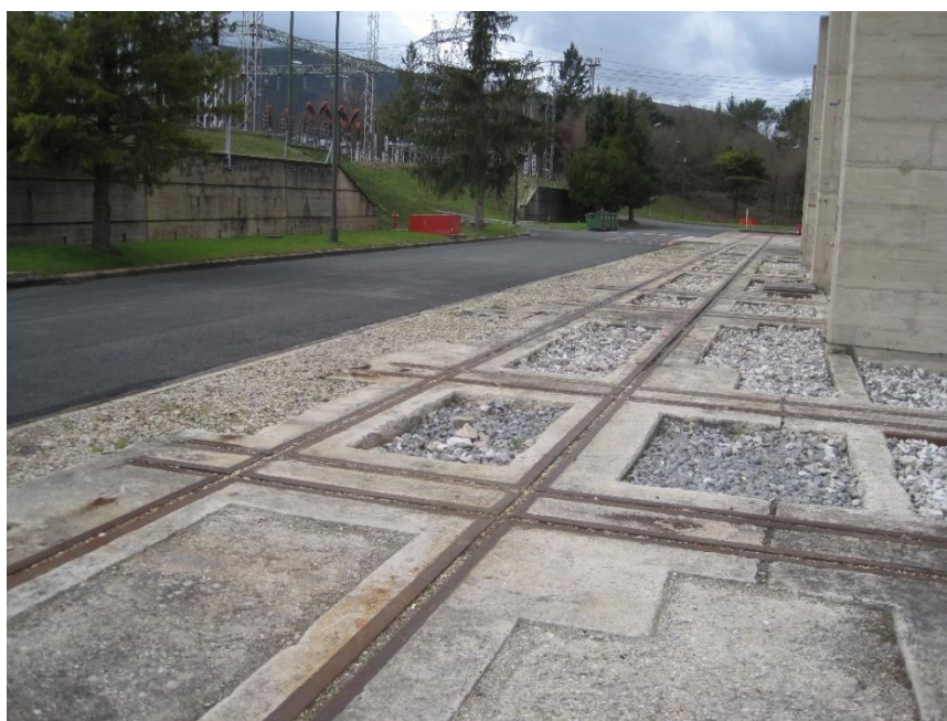
Figura 4-6: Raíles de movimiento de transformadores
