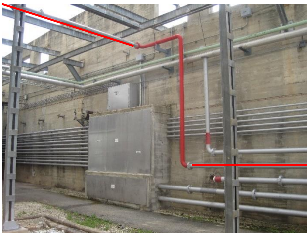
Figura 4-12 y 4-13: Tuberías del sistema contra incendios
