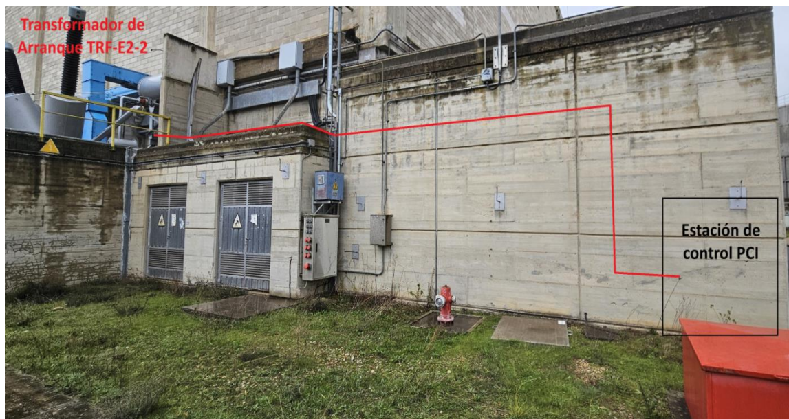
Figura 8-14: Trazado línea de descarga y entrada a área transformador de arranque
