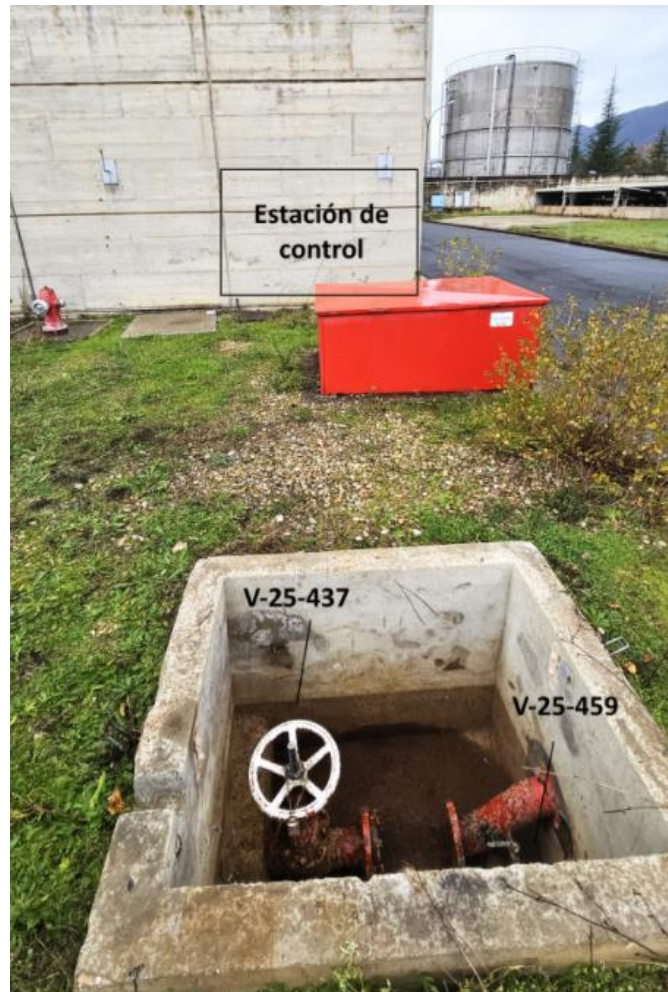
Figura 8-11: Ubicación válvula alimentación V-25-437
