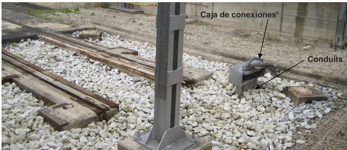
Figura 8-48: Detalle cubeto transformador auxiliar
