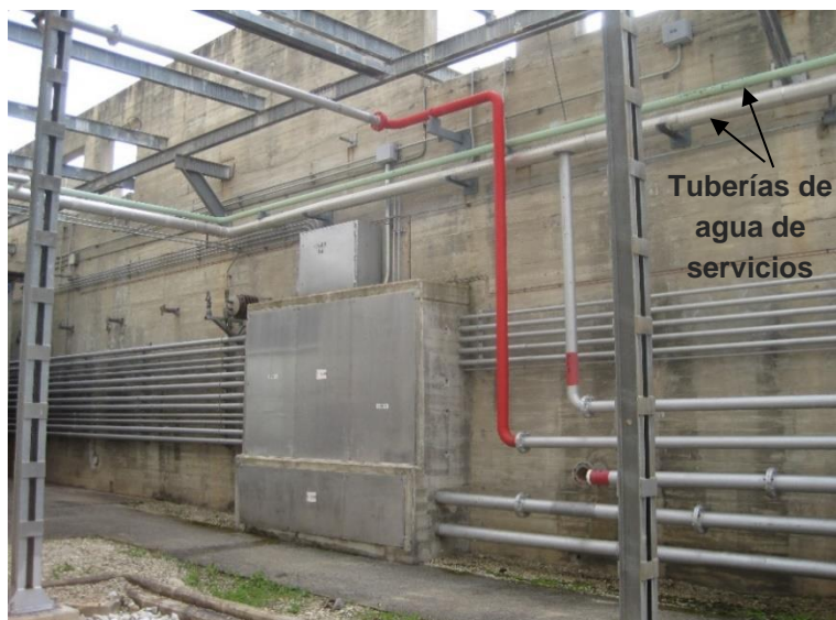
Figura 8-29: Tuberías agua de servicios (SW)
